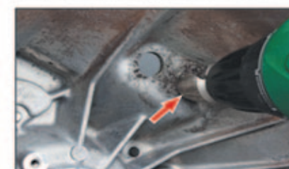
Fig. 5: Ampliación de los orificios con un taladro
