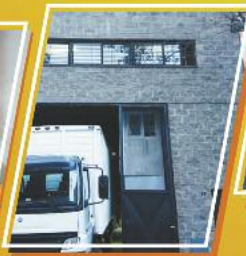
CENTRO DE DISTRIBUCIÓN GIRARDOT
