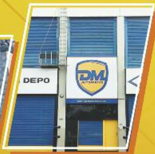
CENTRO DE DISTRIBUCIÓN CÓRDOBA
